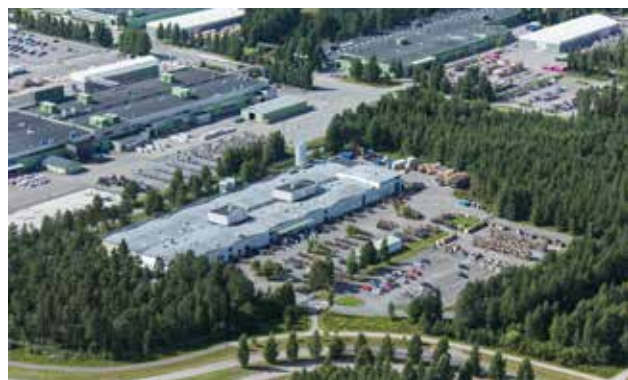
Nestor Cables fabrik i Uleåborg i Finland.
